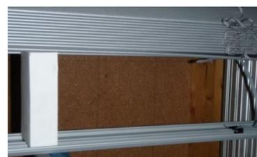
6- Soulever la partie supérieure de la lame finale avec le paquet de lames et maintenir à l'aide de 2 liteaux ou cales.
