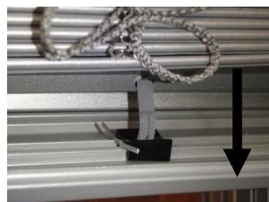
12- Une fois que tous les rubans de levage sont remplacés, enlever les tréteaux ou autre et faire descendre complètement le tablier en l'aidant manuellement.
